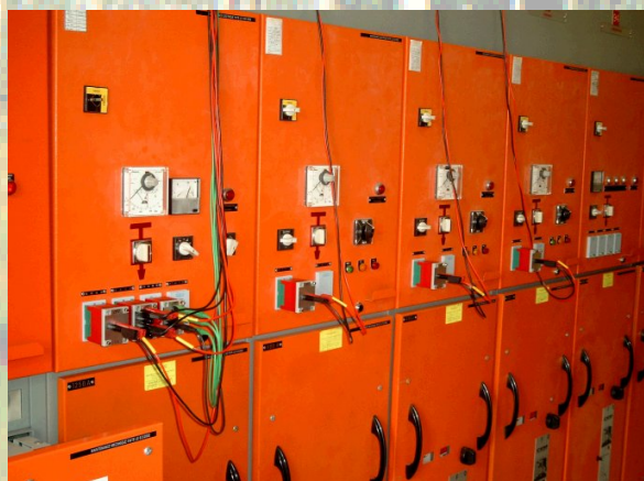
Exemples d'utilisation des boîtiers ESSAILEC en poste source
